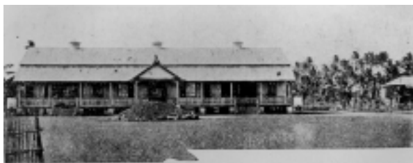
写真1 マキ公学校校舎
